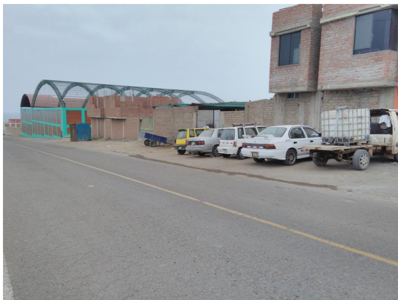
FOTO N° 20: VIA DE EVITAMIENTO–MZ Ñ Falta de infraestructura vial. Requiere la construcción de Veredas, Bermas, Sardinell y Jardineras.
