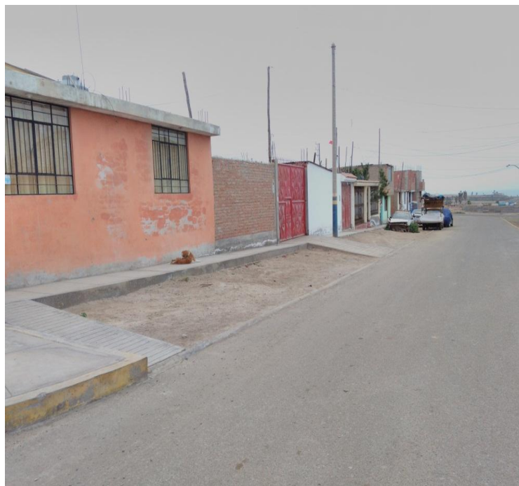
FOTO N° 07: Jr. JUAN PABLO II – MZ Ñ: Falta de Infraestructura Vial. Requiere la construcción de Bermas y Jardineras
