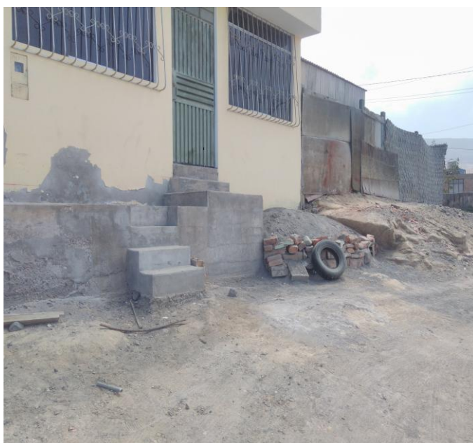
FOTO N° 13: Jr. ESCALAS – MZ L' Demolición de estructuras existentes.
