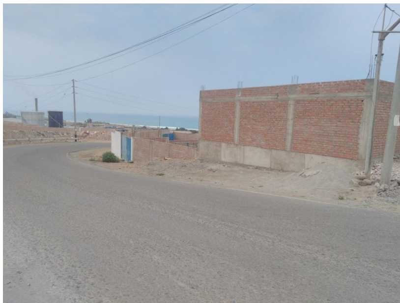
FOTO N° 17: VIA DE EVITAMIENTO– MZ B' Falta de infraestructura vial. Requiere la construcción de Veredas, Bermas, Sardinell y Jardineras.
