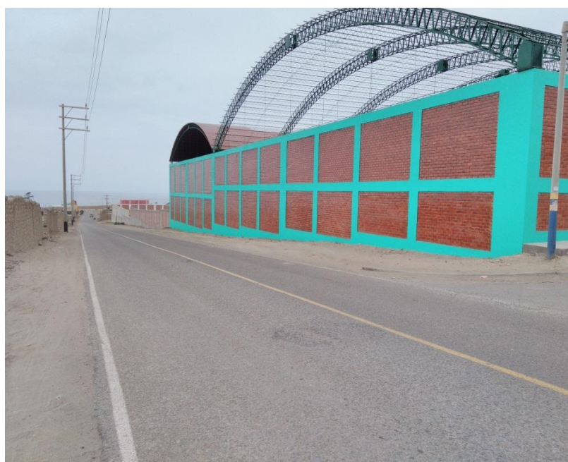
FOTO N° 21: VIA DE EVITAMIENTO–AREA RECREACION Falta de infraestructura vial. Requiere la construcción de Veredas, Bermas, Sardinell y Jardineras.
