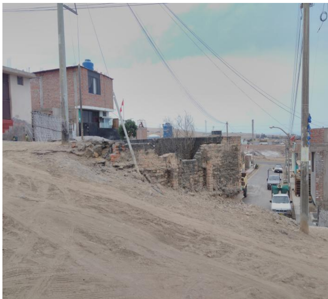
FOTO N° 12: Jr. ESCALAS – JR. PACO YUNQUE: Demolición de estructuras existentes.
